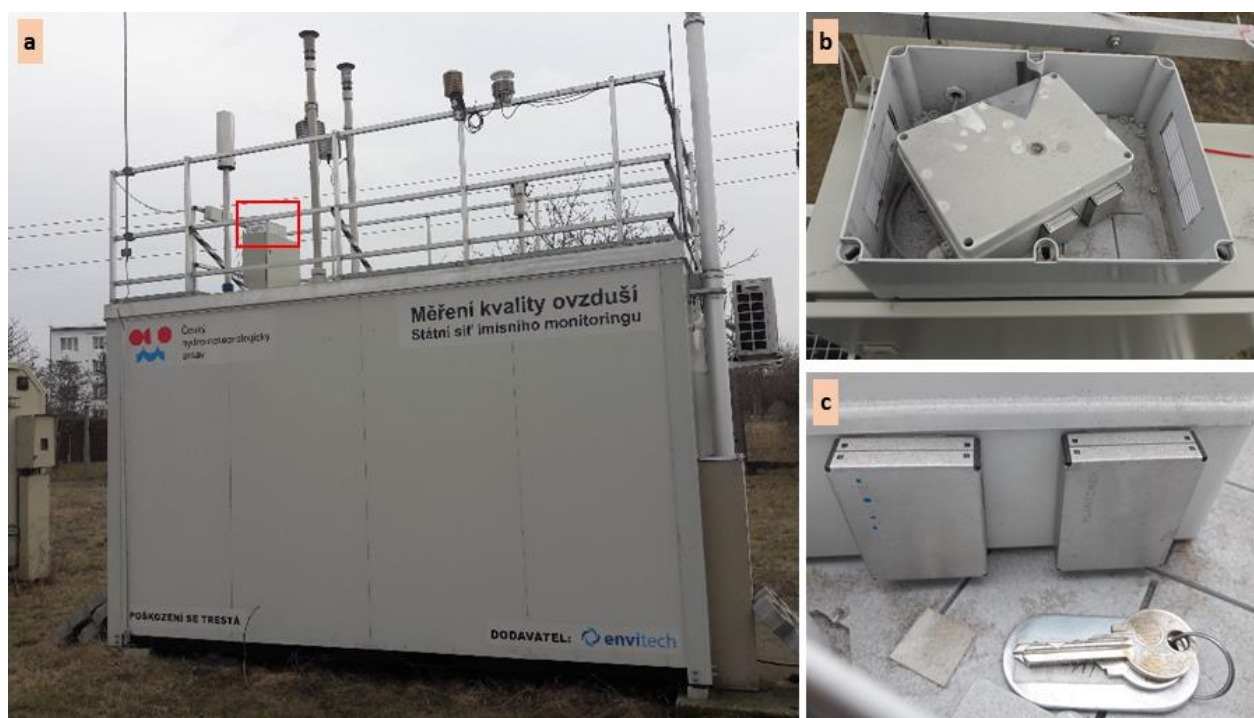
Obr. č. 9. Párová sada prachoměrů Plantower PMS7003 (c) instalovaná v průvzdušném boxu (b) umístěném na střeše referenční stanice AIM na Observatoři v Tušimicích (a). Foto: P. Bauerová
