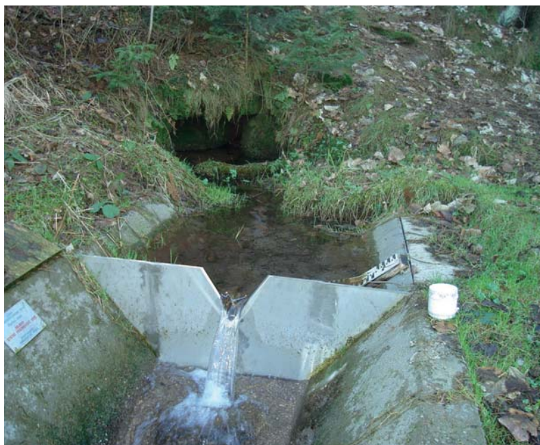
Foto 7.2 Pramen PPO744 Želechy (před rekonstrukcí) s vysokou vydatností 1,11 l.s -1 v září 2009. Pramen vyvěrá v severovýchodních Čechách v oblasti Podkrkonošského permokarbonu (hg rajon 5151), je součástí odvodnění pánevní oblasti s horninovým zastoupením slepenců.
