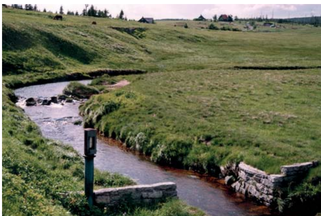
Obr. 2 Fotka původní stanice z roku 1985, průběh vodního stavu byl zaznamenáván limnigrafem, (zdroj: archiv ČHMÚ Jablonec).
