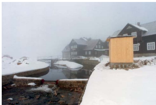
Obr. 3 „Nová“ stanice z roku 1997, stabilizace dna zděným prahem, který je uprostřed snížen a opatřen měrným přelivem, datalogger Seba umístěn v dřevěné budce, vodní stav je měřen tlakovým čidlem i klasickým limnigrafem, (zdroj: archiv ČHMÚ Jablonec).
