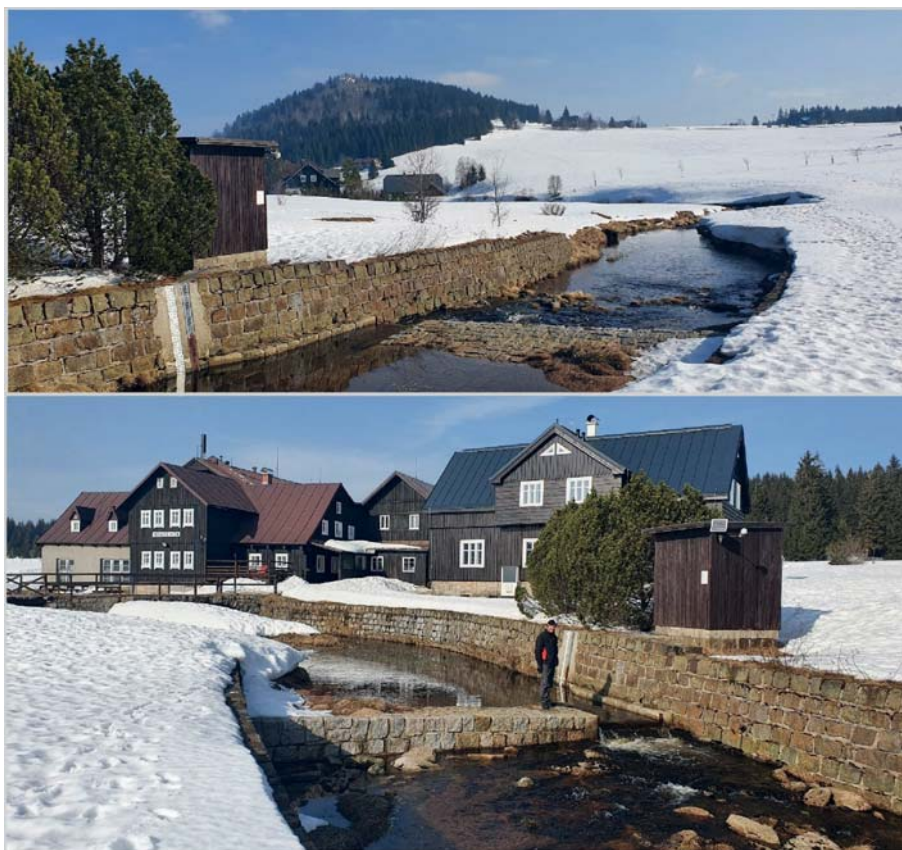
Obr. 4 Současný stav vodoměrné stanice, po rekonstrukci prahu v roce 2015 jsou běžné průtoky převáděny přes měrný přeliv u levobřežní zdi v blízkosti vodočtu a tlakových čidel. I při minimálních vodních stavech je tak dosaženo kvalitního vyhodnocení průtoků.
