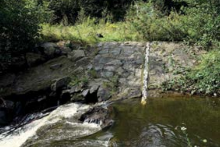
Obr. 45 Vodoměrný profil pro Barnovskou vodní nádrž. Foto: Jan Unucka, 2022
