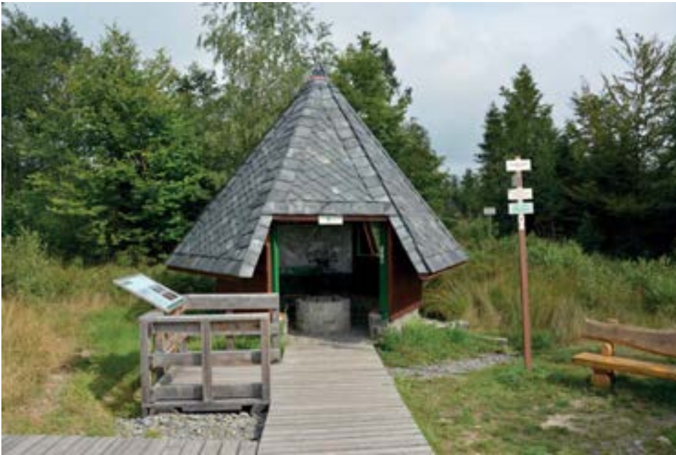
Obr. 60 Detail dřevěné besídky nad Dolním pramenem Odry. Foto: Petr Tušil, 2022
