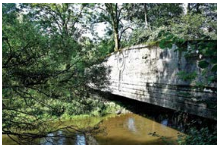
Obr. 44 Barnovský most na Odře. Foto: Jan Unucka, 2022
