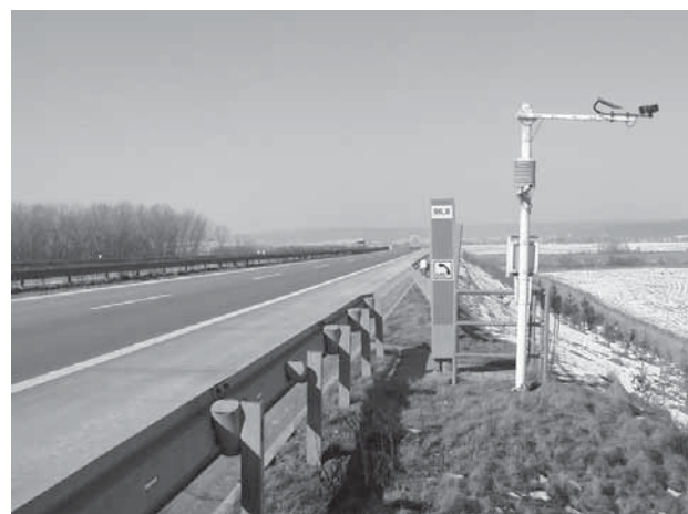
Obr. 1 Silniční meteorologická stanice technologie Vaisala (v tomto případě bez měření větru), používaná zejména v dálniční síti.
