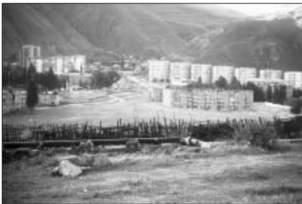
Obr. 1 Pohled na poničenou část města Tyrnauz. Foto J.Křena, též obr. 2.
