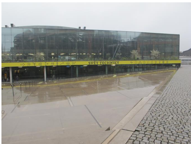
Obr. Objekt Velkého světa techniky
